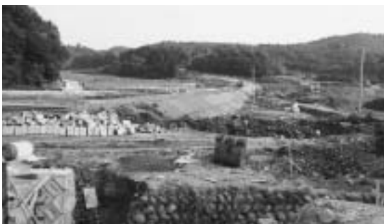
工事が始まった農免道路（小原地内）
