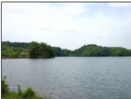
前沢ダムの様子
