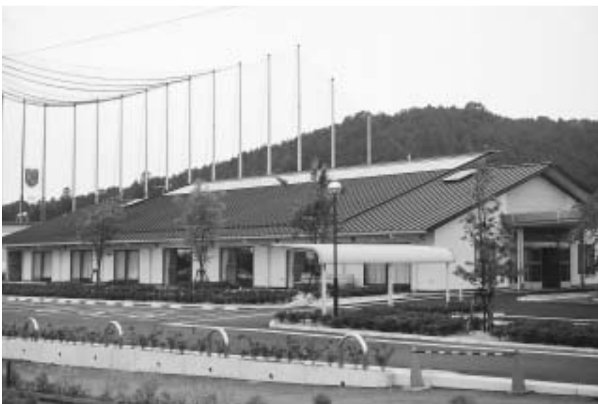
OMソーラーを屋根に設置した「あゆみ館」
