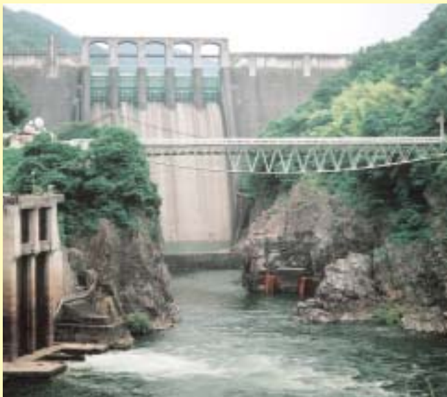
小和沢橋（つり橋）の手前が工事用の仮橋です
