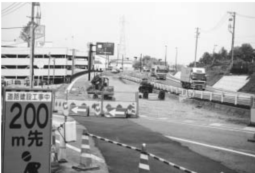
車線部分を暫定的に供用開始（第四工区）
