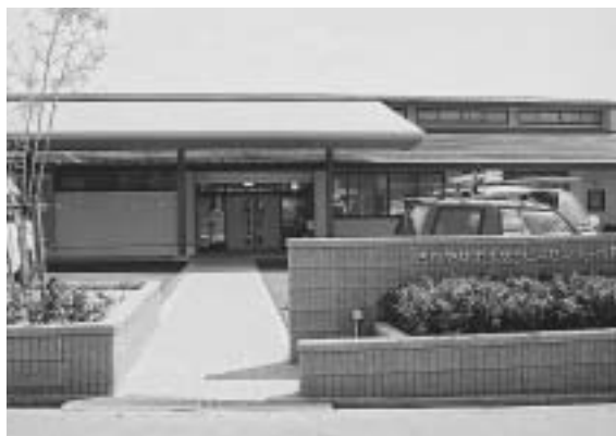
竣工した「さわやかデイサービスセンター伏見」
